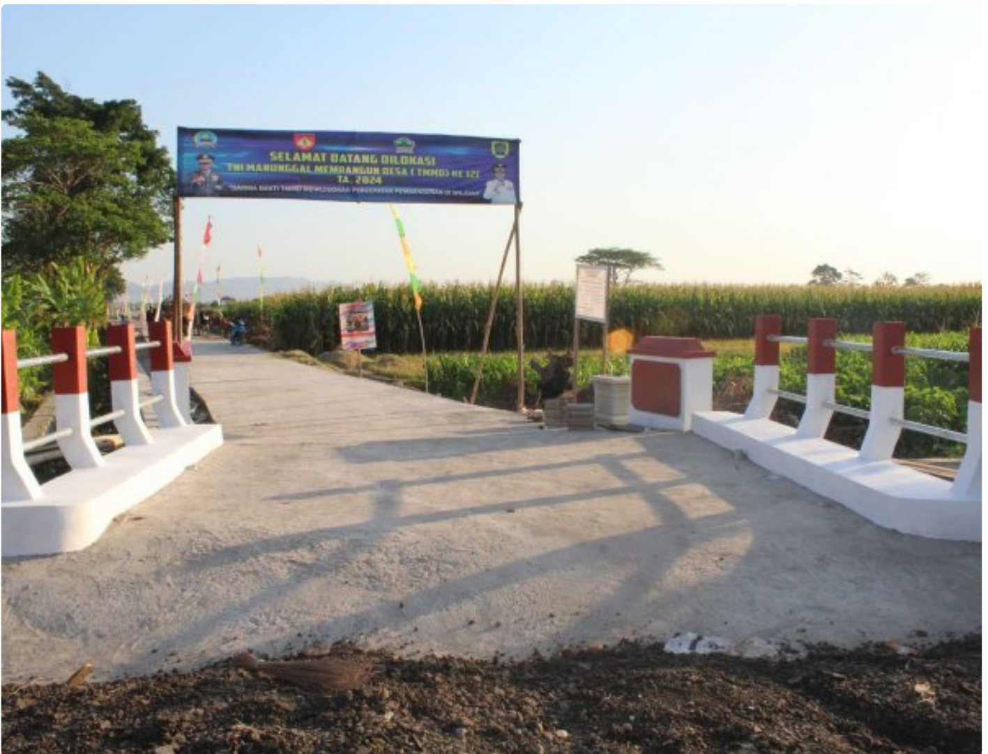
Dandim Klaten Berharap Warga Merawat Jembatan TMMD
